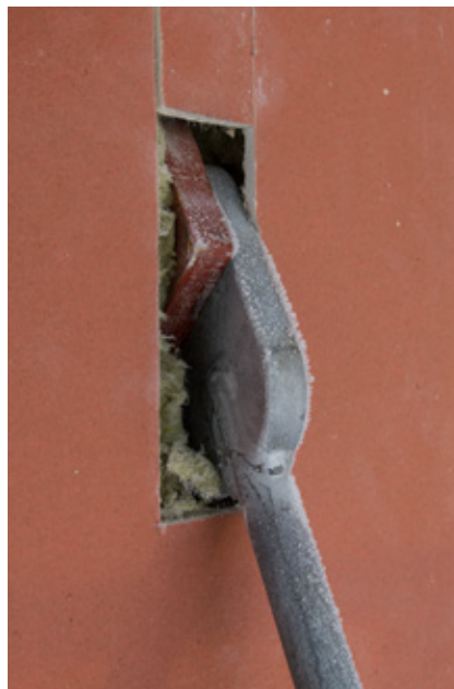
Viser innfesting mot sveiseplate mot fasade.
