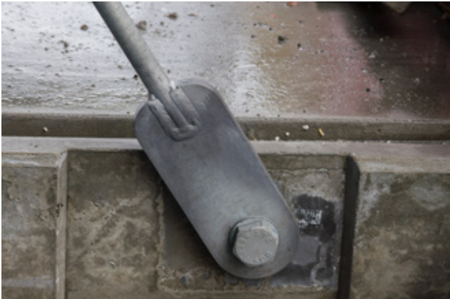
Viser innfesting mot innstøpt plate med gjengehylse i balkongdekke.
