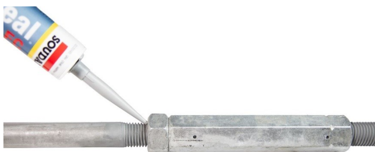
Figur 3: Påføring av tettemasse
