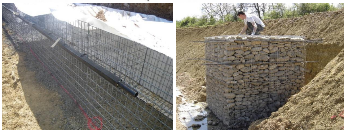
Fig. 5 – Detalj av innfesting av stillasrør ved sammenføyningen mellom frontpaneler og skillevegg.
