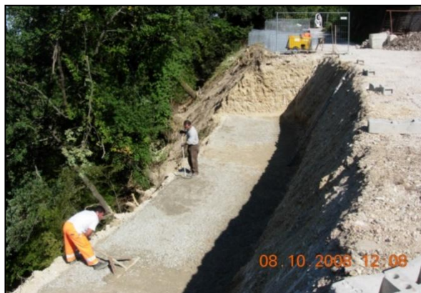
Fig. 8 – Avretting av fundament for gabioner
