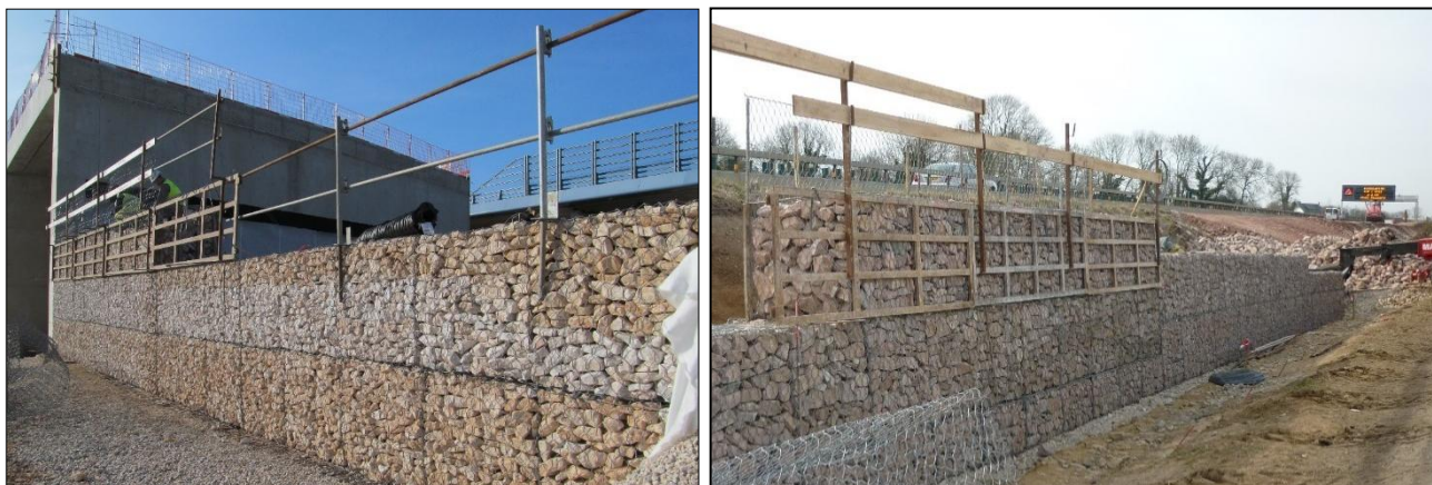
Fig. 37 – Sikkerhetsutstyr på TMS-enhetene (eksempler som er relevante for DT-gabioner)
