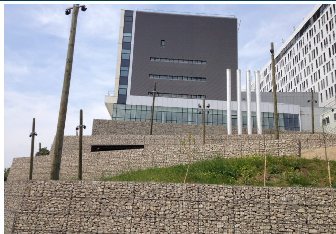
Figur 1: Eksempel på bruk av sveiseede gabioner med Galmac® C3
